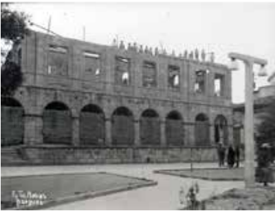
Nuevo edificio en proceso de construcción de la actual Gobernación del Cañar 60
