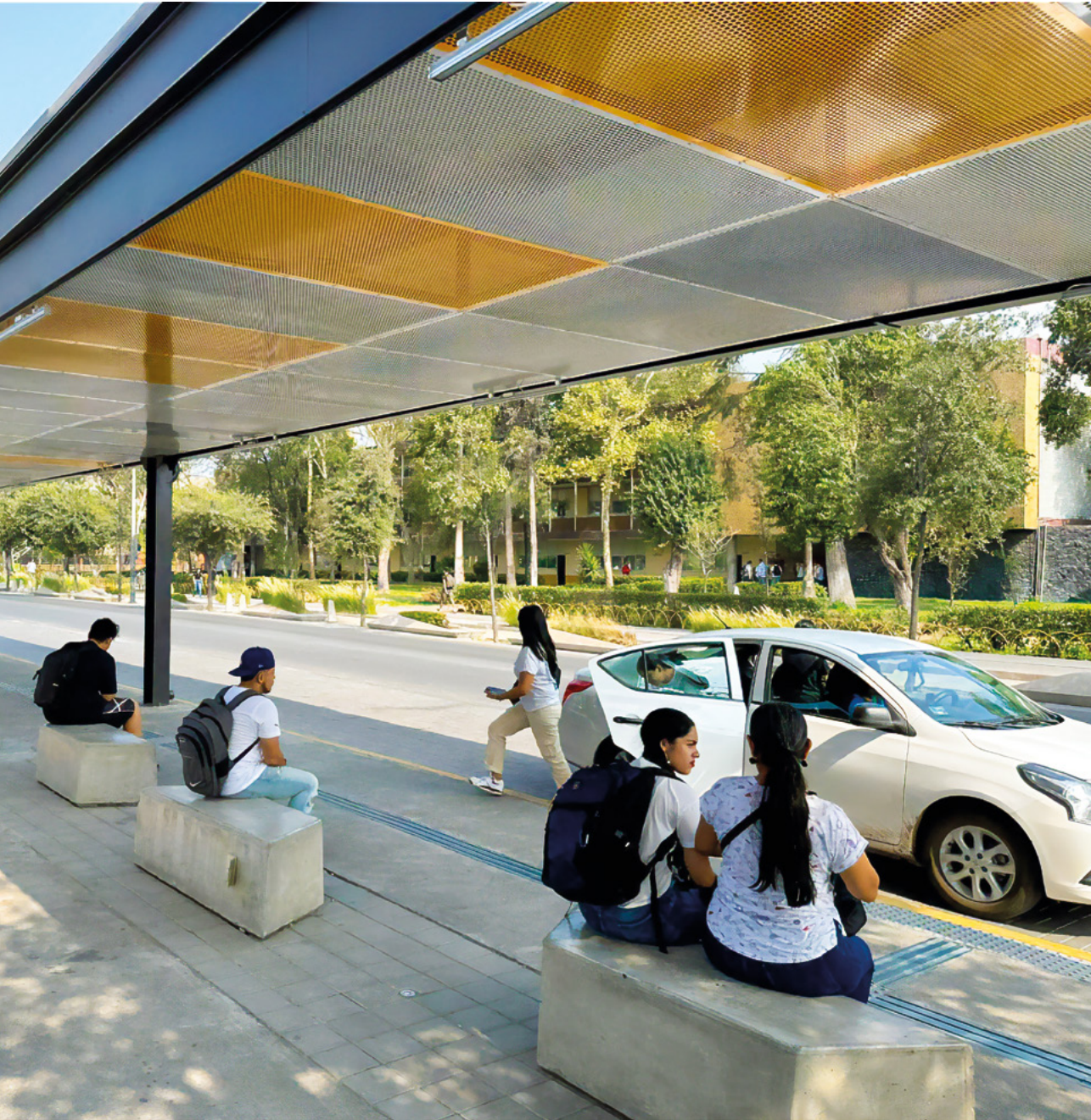
Nota. Las cubiertas se aplicaron frente a la Facultad de Ingeniería Civil, en el Campus Ciudad Universitaria. Imagen de Roberto López, bajo la dirección arquitectónica de la DPOEEU (julio, 2023).
