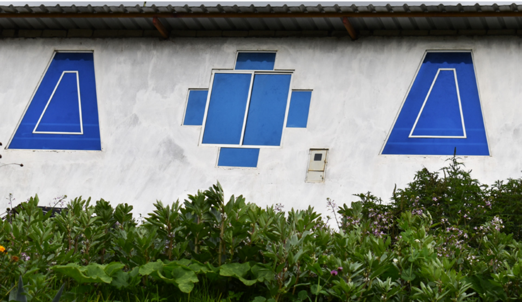
Ventanal con chakanas integradas en la comunidad Quilloac (cantón Cañar)
