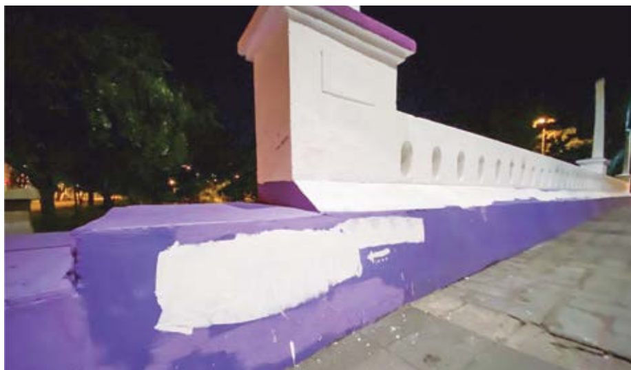
Fotografía 5 Blanqueamiento del Puente Vivas Nos Queremos
